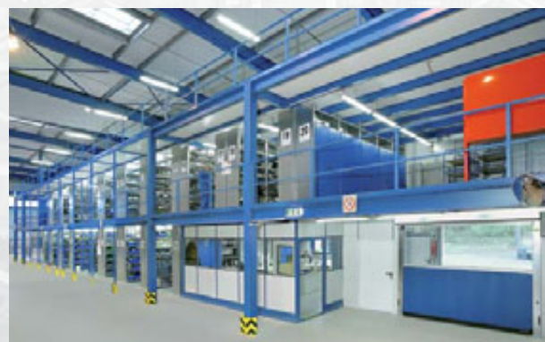
Um eine reibungslose Kommissionierung zu gewährleisten, wurden 2 Büroräume und eine Thekenvorrichtung in die Fachbodenregalanlage integriert
