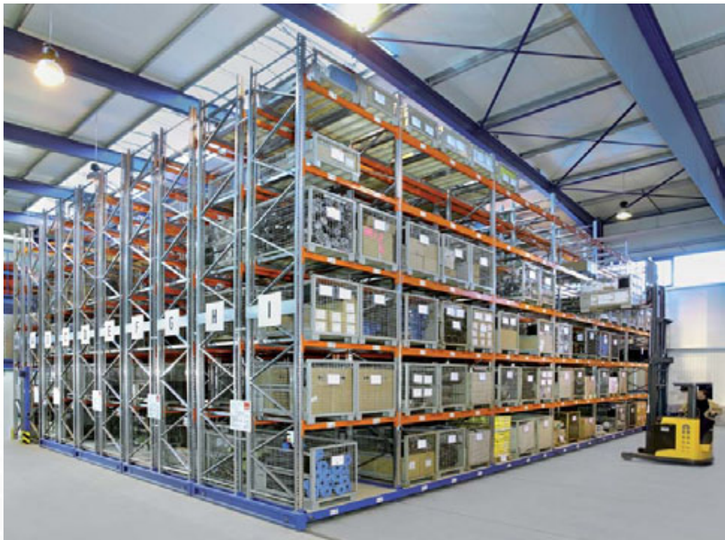
Die verfahrbare META MULTIBLOC® Palettenregalanlage besteht aus 2 stationären Einheiten und 8 Wagen
